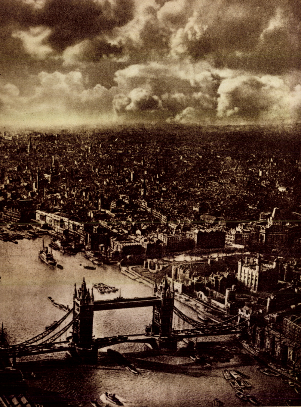
LONDÝN: Londýnská City, Tower na pravém břehu Temže a towerský most.
